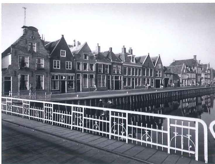
12 Doorspronkelijk leuningwerk Franekereindsbrug (1960). (© MSH)
