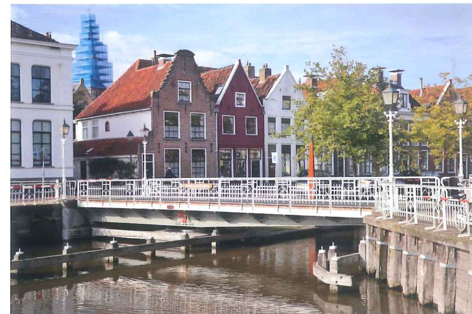
18 Franekereindsbrug na de restauratie. (© dBdG)
