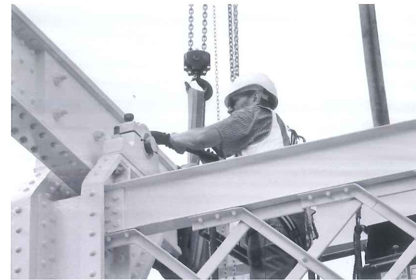
↑↓ 5 a en b Oosterbrug: detail hameipoort met vakwerk hameiregel en draaipunt balans. (© Ars)
