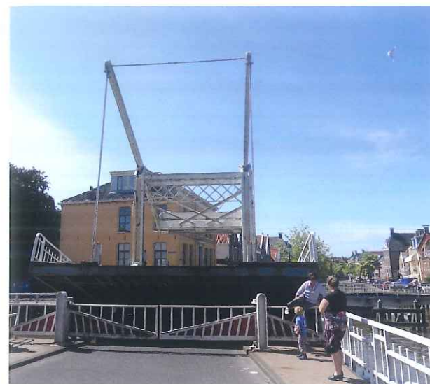
Gesloten afsluithekken Oosterbrug. (Ars)
