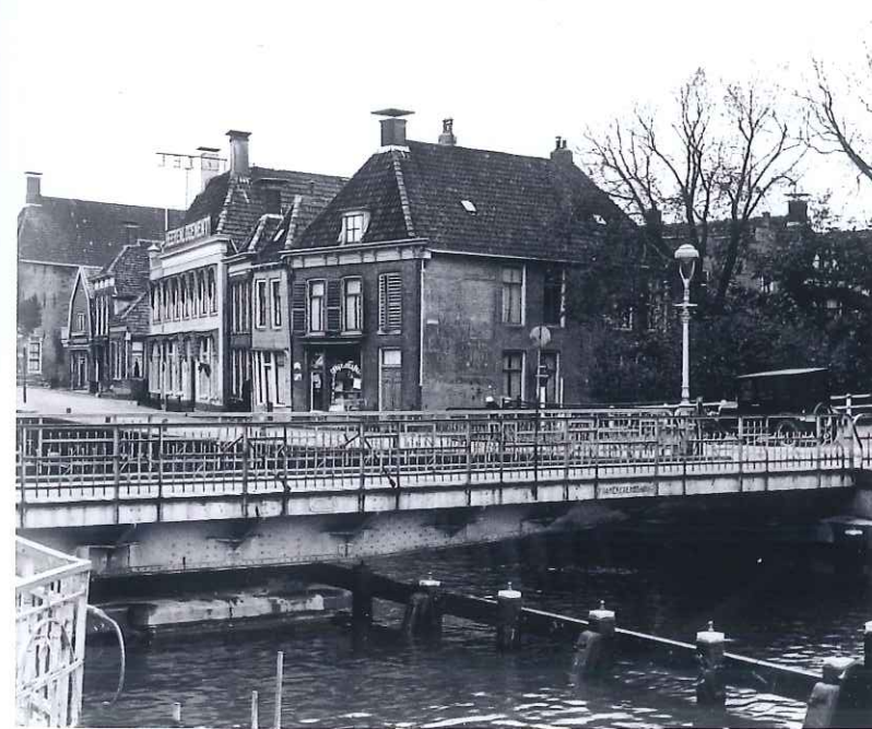
9 Franekereindsbrug in 1930. (© MSH)
