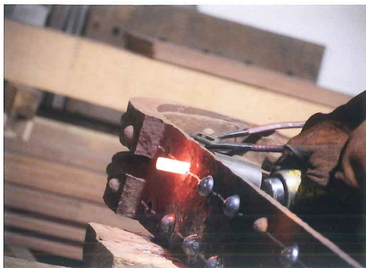
13.a Aanbrengen klinknagel. (© dBdG)
