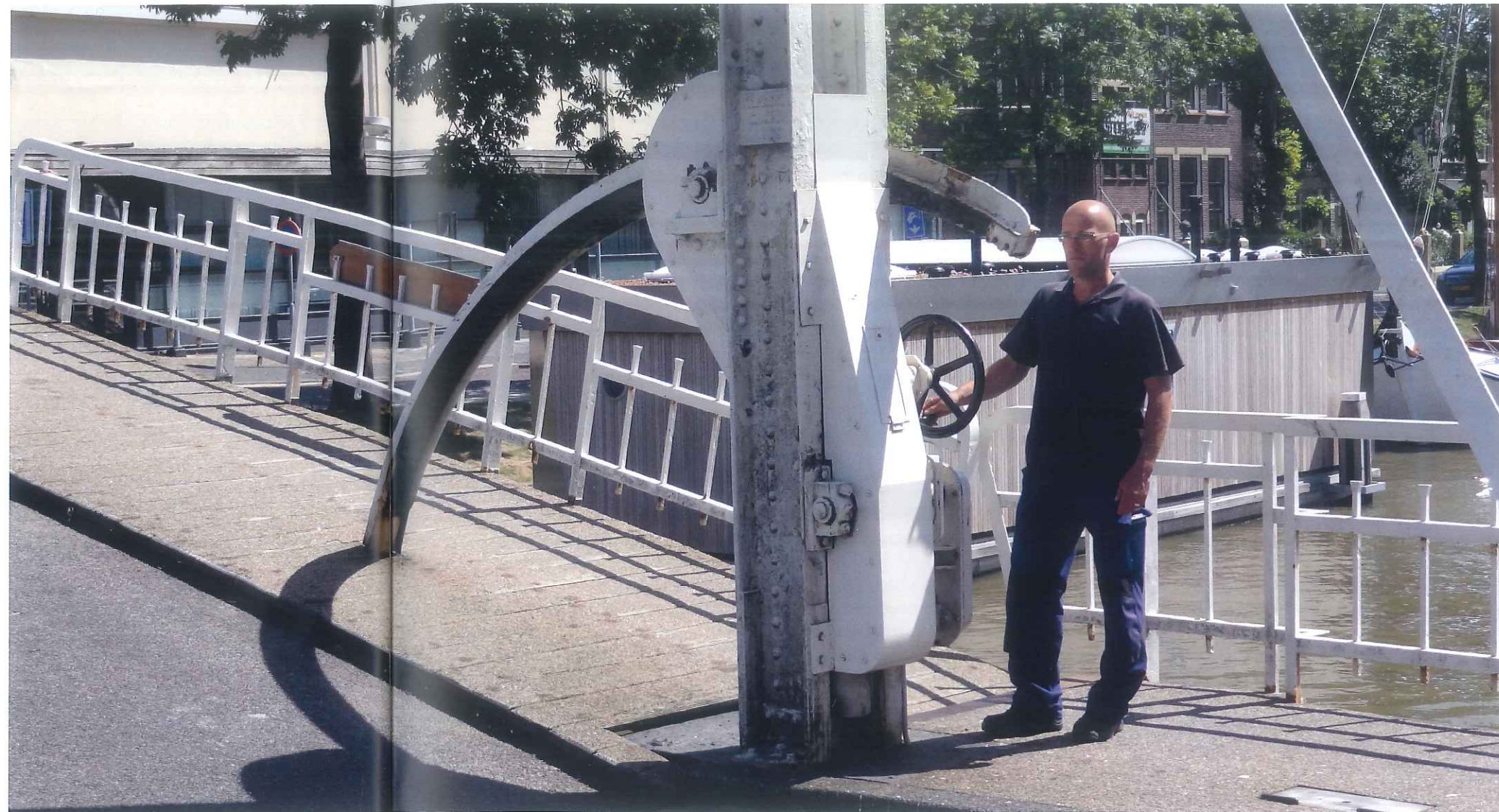
7 Bewegingswerk Oosterbrug met hydraulische motor; de balustrade dateert uit 1952 (© Ars)
